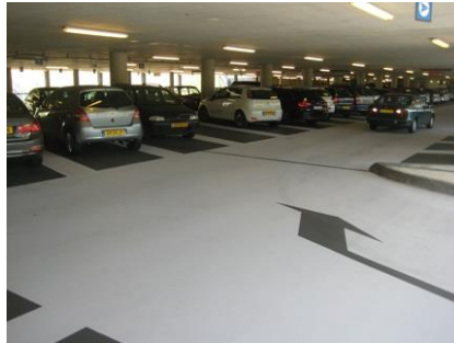
Duidelijke routing en goed aangegeven parkeerplaatsen door het gebruik van een andere kleur.
