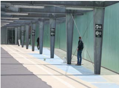
Aanbrengen van het Triflex Speciaalvlies als onderdeel van het volledig gewapende systeem
