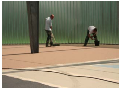
Instrooiing kwartszand, korrelgrootte 0,7 – 1,2 mm
