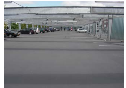
Het eindresultaat! Een parkeerdek zonder zichtbare scheurvorming
