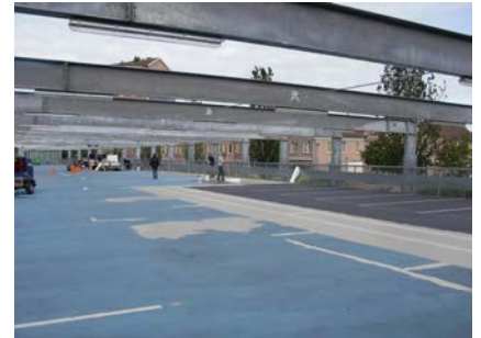
Aanbrengen van de eerste laag Triflex ProTerra
