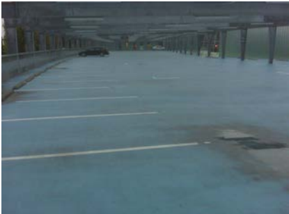
Het parkeerdek voor de complete renovatie
