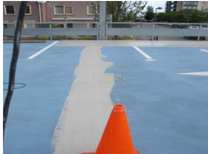
De dilataties voorzien van het Triflex Speciaalvlies
