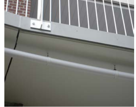
Ook de onderkant van de galerijen is voorzien van het Triflex ACS systeem.
