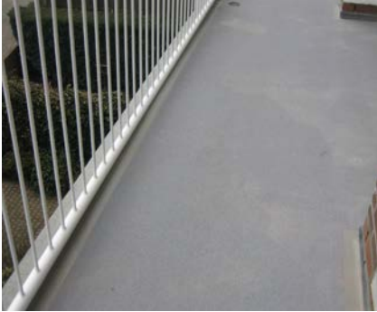
De galerijen zijn voorzien van het scheuroverbruggende Triflex BTS-P systeem
