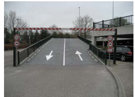
Ook de hellingbaan is voorzien van een gewapend Triflex systeem.
