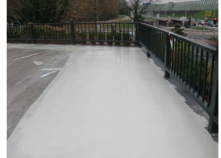
Vervolgens is het gehele parkeerdek voorzien van het waterdichte en scheuroverbruggende membraan.
