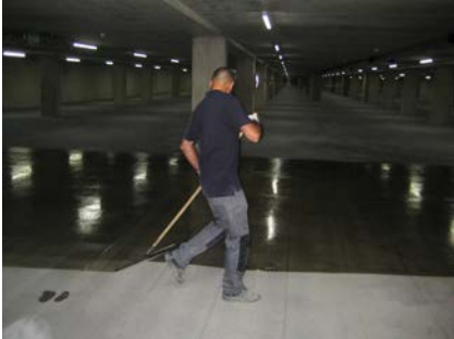
Nadat de cementhuid verwijderd is, wordt het vloerveld voorzien van een Triflex Primer.
