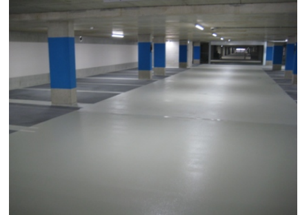
Ook de rijbanen zijn voorzien van een duurzaam coatingsysteem.
