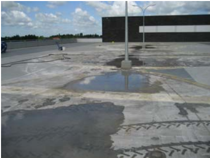
Om een goede hechting aan de ondergrond te kunnen garanderen werd de afwerking verwijderd.
