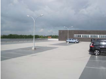
Het parkeerdek werd in 2008 voorzien van een afdichtende laag,
