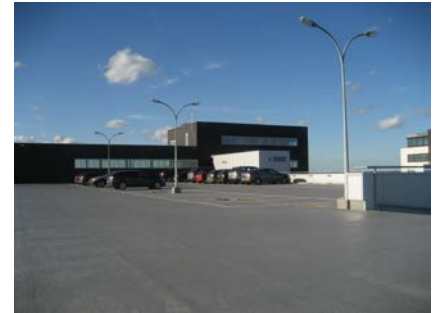
er een waterdicht eindresultaat is ontstaan, zonder scheurvorming!
