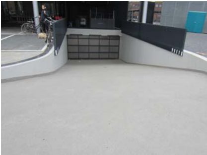
Door de hellingbaan te voorzien van het Triflex ProPark systeem, variant 3 behoudt deze dezelfde uitstraling als het parkeerdak.
