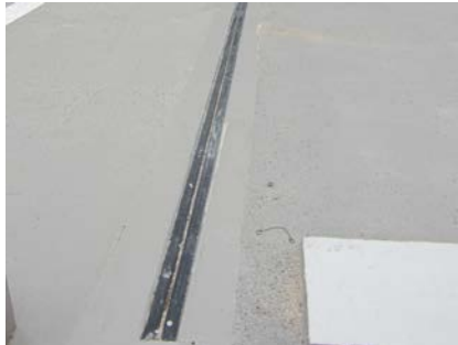
De dilatatie is volledig geïntegreerd in het Triflex systeem.
