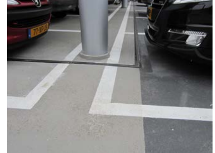
Om de parkeervakken duidelijk aan te geven is Triflex markering gebruikt.
