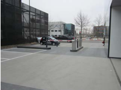
Vanaf de straat is het parkeerdak voorzien van een coatingsysteem.
