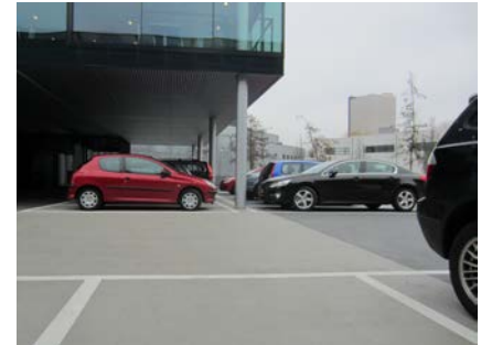
Het eindresultaat: Een parkeerdak die volledig aansluit bij de uitstraling van het pand.
