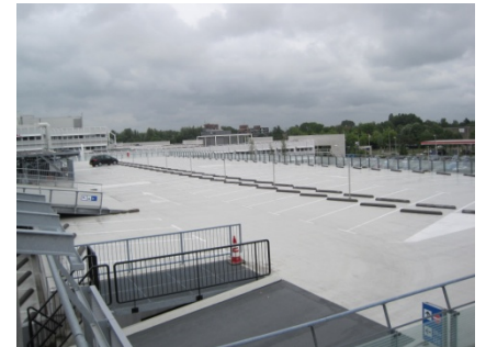
Het parkeerdak is voorzien van het Triflex PDS-T systeem
