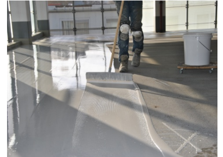
Aanbrengen Triflex Cryl RS 246
