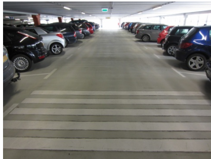
Het eindresultaat: De binnendecken voorzien van het Triflex DCS-C systeem
