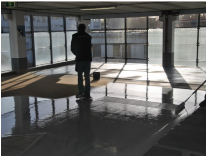
Vuurgedroogd kwartzand vol en zat in de nog vloeibare Triflex Cryl RS 246 instrooien
