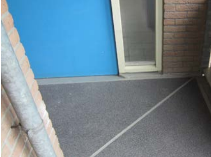
De drempelhoogte is weggenomen door het Triflex ophoogsysteem.
