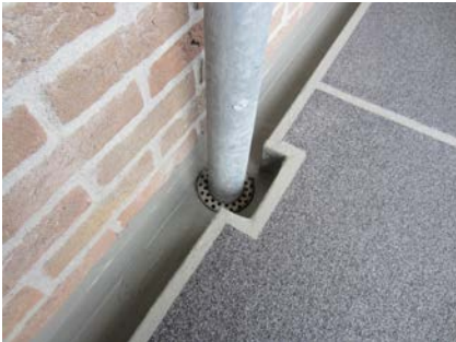
Doordat het ophoogsysteem makkelijk aan te passen is, hoeven de hemelwaterafvoeren niet verplaatst te worden.
