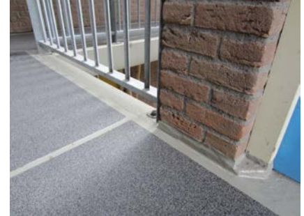
Alle details zijn voorzien van het gewapende membraan om lekkageproblemen te voorkomen.
