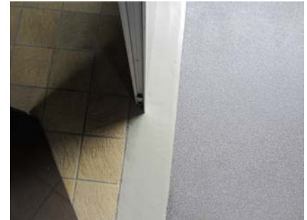
De overgang naar binnen is gelijkvloers gemaakt, zodat de bewoners zich gemakkelijk kunnen verplaatsen.
