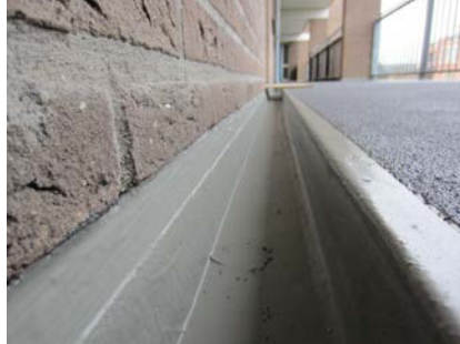
De goot is voorzien van het waterdichte membraan.
