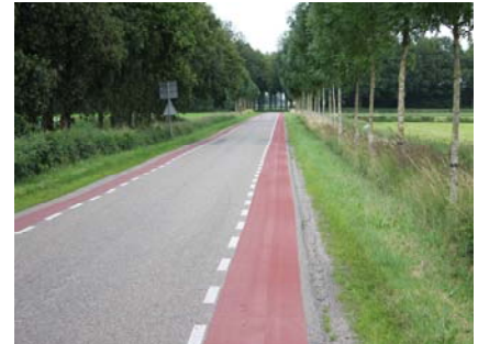
De Staldijk na het aanbrengen van Preco Cryl Reibeplastik 2K
