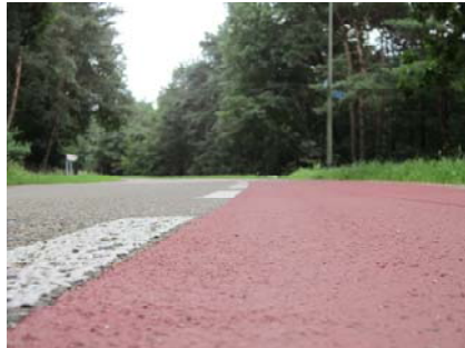
Preco Cryl Reibeplastik 2K geeft een voldoende stroef oppervlak om valpartijen te voorkomen
