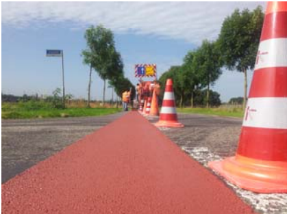
Om de veiligheid van de wegwerkers te waarborgen is een gedeelte van de weg afgezet
