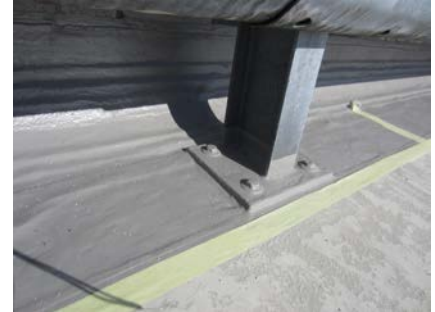
De details worden voorzien van het waterdichte Triflex membraan
