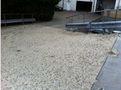
De hellingbaan voor de renovatie
