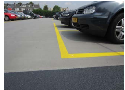
Het parkeerdek na de renovatie
