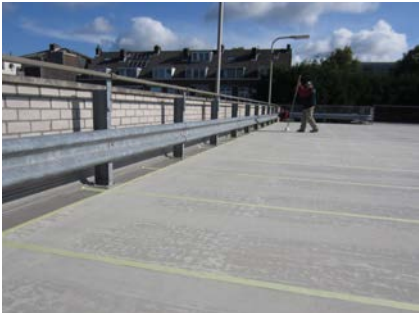
Het vloerveld is voorbehandeld om vervolgens het Triflex PDS-T systeem aan te brengen
