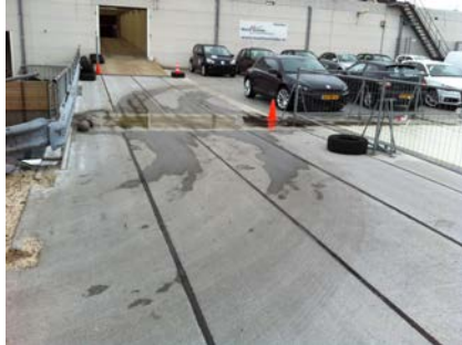
Het parkeerdek voor de renovatie
