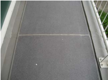
Een dilatatie na de renovatie
