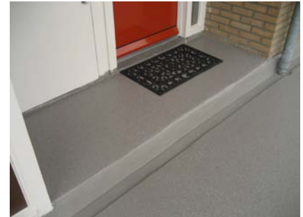
Het bordes na de renovatie
