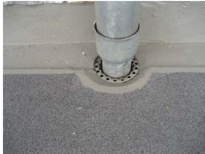
De goot en hemelwaterafvoer na de renovatie
