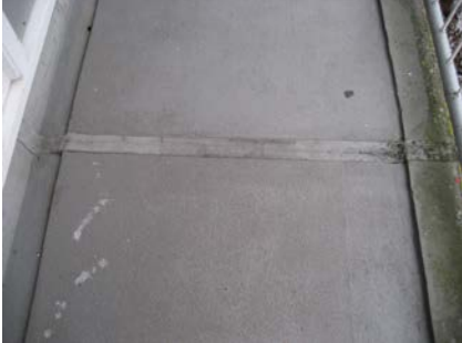
Een dilatatie voor de renovatie
