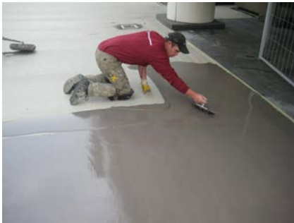
Nadat het vloerveld volledig voorzien is van een gewapend membraan wordt de kleurfinish aangebracht,
