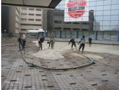
De gewapende betonnen druklaag wordt aangebracht
