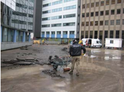
Verwijderen van de bestaande afwerking
