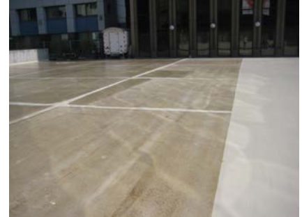
Alle aansluitingen, inzagingen, dilataties en putten zijn voorzien van het Triflex membraan
