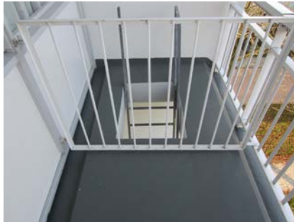
De toegang tot de noodtrap is ook voorzien van het Triflex systeem
