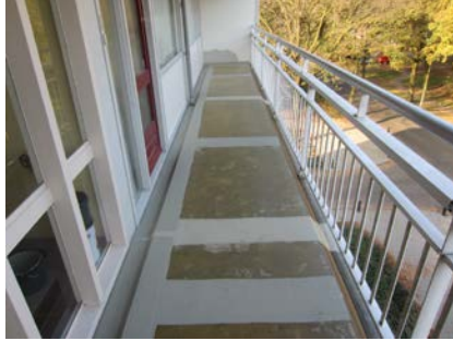
De plaatnaden en dilataties voorzien van het Triflex membraan
