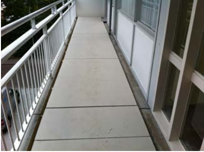
De galerij voorzien van het Triflex ophoogsysteem
