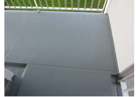
De plaatnaden en dilataties zijn in het Triflex systeem geïntegreerd
