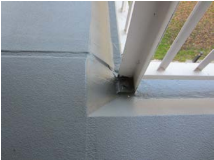
Elk detail voorzien van het waterdichte Triflex systeem
