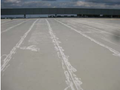
Vorbereiding van de ondergrond
