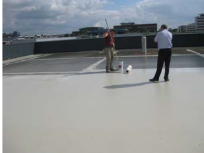
Het vloerveld wordt voorzien van het scheuroverbruggende membraan
