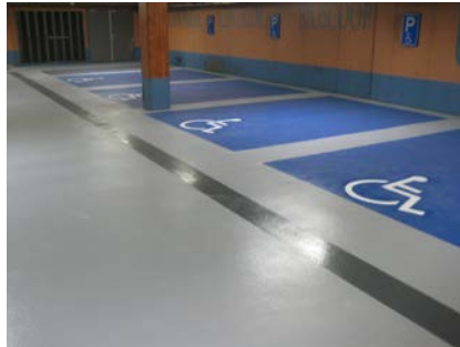
Het eindresultaat: Door het gebruik van verschillende kleuren is de parkeergarage duidelijk en overzichtelijk.
