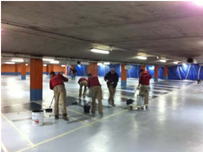
Op verzoek van de opdrachtgever zijn de parkeervakken, voetgangersstroken en belijning in een andere kleur aangebracht.
