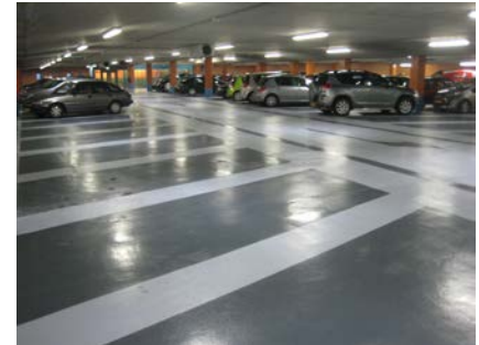
Door de renovatie is de parkeergarage het visitekaartje van Boscotonde geworden.
