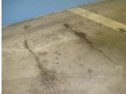
Maar vertoonde ook veel scheurvorming.
