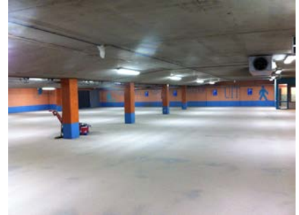
Op het vloerveld is een kwalitatief hoogwaardige coating aangebracht.
