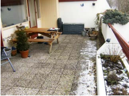
De balkons van VvE Laathof met betonnen tegels.
