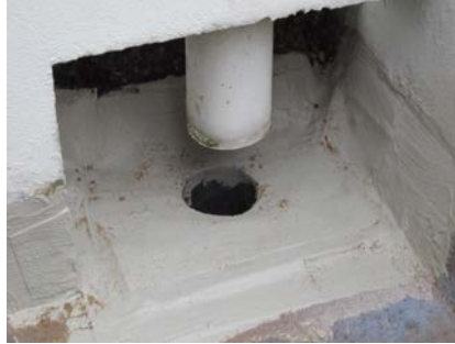
Ook de hemelwaterafvoeren zijn voorzien van het waterdichte Triflex membraan.
