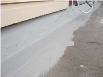
De gevelaansluiting waterdicht ingewerkt met het Triflex ProDetail membraan.
