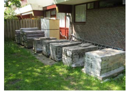
De betonnen tegels zijn opgeslagen om later teruggeplaatst te worden.
