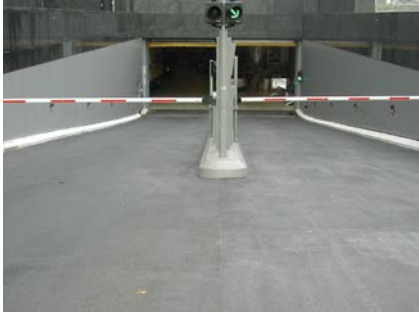
In 2000 is voor het eerst een volledig gewapend systeem van Triflex aangebracht
