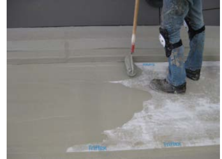
het verwarmingssysteem gaf echter zoveel problemen dat het vloerveld opnieuw voorzien moest worden van een afdichting.
