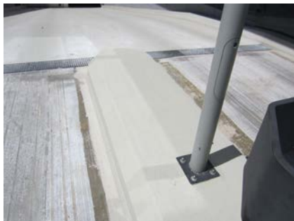
Waarbij wederom alle details voorzien zijn van het waterdichte Triflex membraan.
