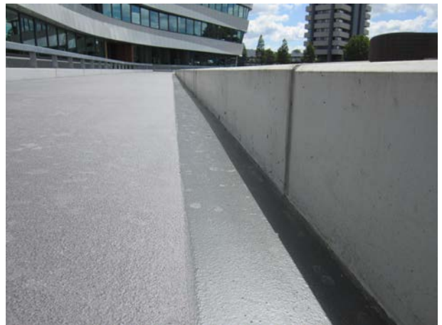
Door het aanbrengen van het Triflex systeem, heeft de wandelbrug de uitstraling en gewenste stroefheid gekregen.
