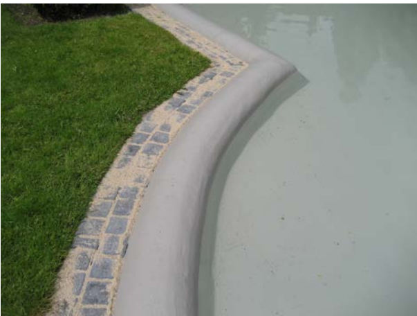
Door de vijver af te dichten met het volledig gewapende Triflex systeem behoren de lekkageproblemen tot het verleden. Bijkomend voordeel is dat de vijver een frisse en mooie uitstraling heeft gekregen.
