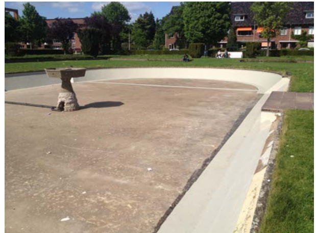
Door de randen en de dilataties van de vijver af te dichten met Triflex ProDetail, behoren de lekkageproblemen tot het verleden.
