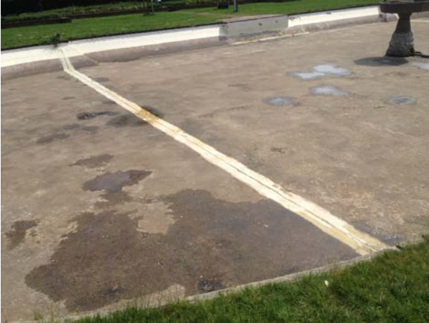
De vijver vertoonde veel scheuren in de constructie waardoor lekkageproblemen zijn ontstaan.
