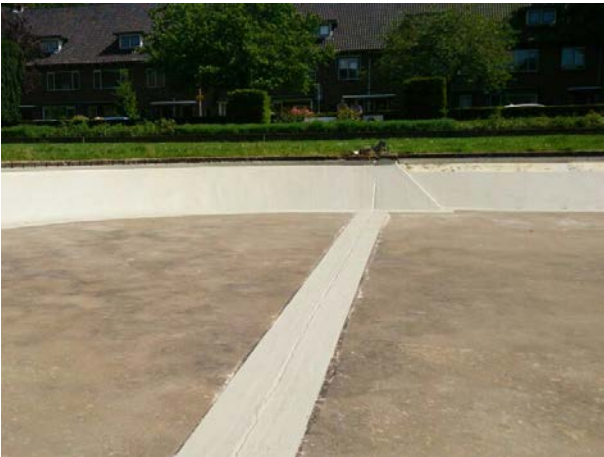
Door de randen en de dilataties van de vijver af te dichten met Triflex ProDetail, behoren de lekkageproblemen tot het verleden.
