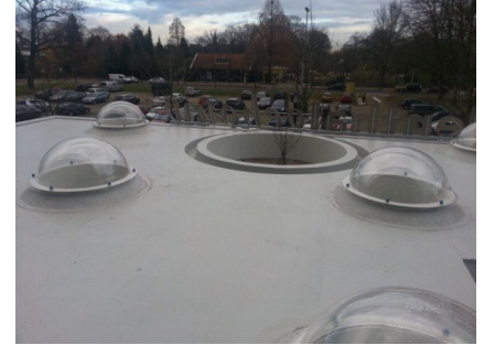
Er zijn 10 ronde dakkoepels aangebracht ,
