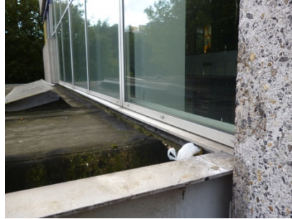
paste niet meer bij het renovatie ontwerp, waardoor er gekozen is om Triflex te gebruiken.
