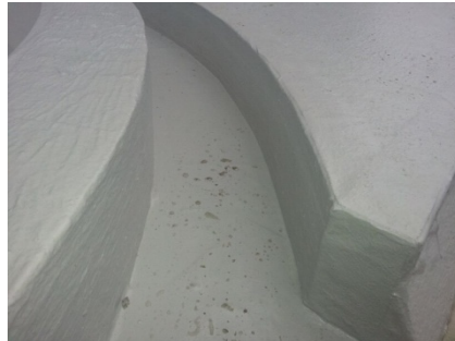
Maar ook een goede goot om het overtollige regenwater af te voeren.
