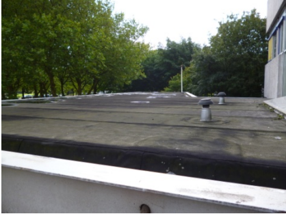
Traditionele dakbedekking op de luifel bij de ingang van het wiskundig gebouw,
