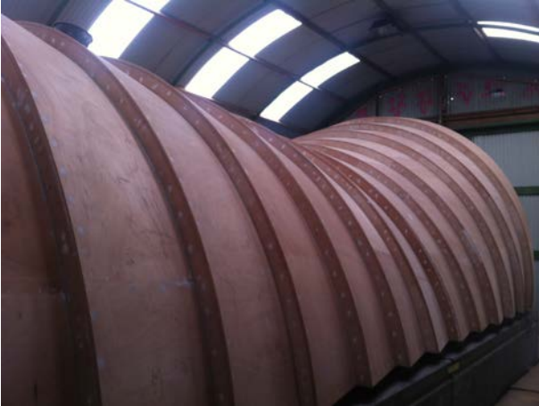
Het raamwerk met houten beplating.
