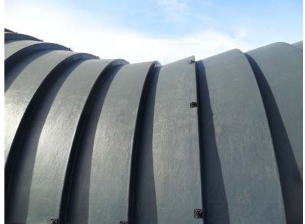
Het golfpatroon is zorgvuldig voorzien van Triflex ProProtect en ProDetail.
