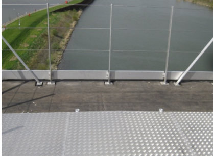
Dakoppervlak met het nieuwe hekwerk
