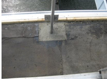
Uitvullen van de gaten ten behoeve van de staanders van het hekwerk met Triflex Cryl RS 240
