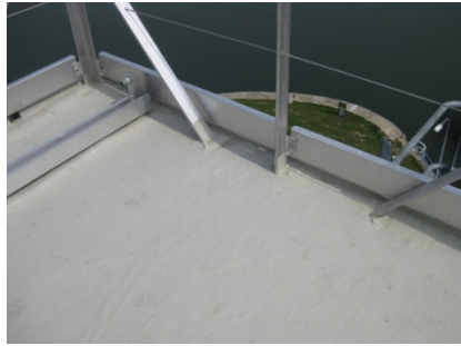
De details zijn voorzien van Triflex ProFibre en het dakoppervlak is voorzien van het Triflex ProTect systeem
