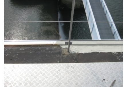
De randen voorzien van het Triflex membraan
