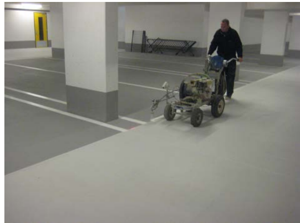
En als laatste worden de lijnen aangebracht.
