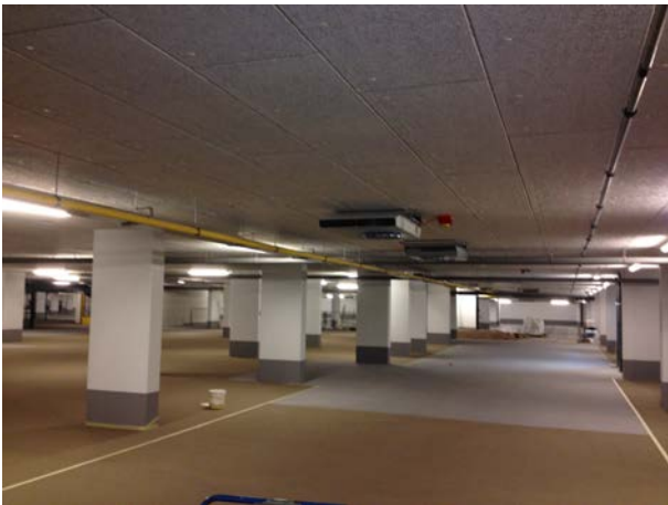
Deze laag wordt ingestrooid en voorzien van twee lagen Triflex Pox Finish 151.
