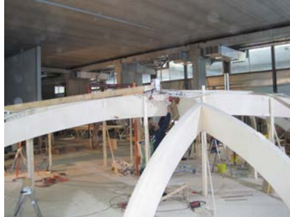
In elkaar zetten van de houten dakconstructie
