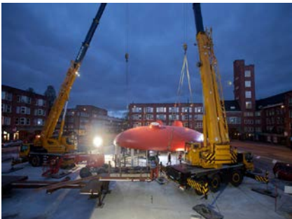
Het plaatsen van de houten dakconstructie
