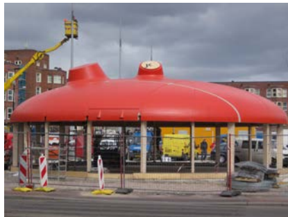
Het dak zit op zijn plaats. Nu de verdere afwerking nog.
