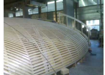
De houten dakconstructie compleet
