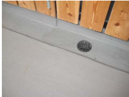
Ook de randaansluiting en putten zijn van een waterdichte afwerking voorzien.
