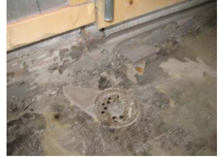
Ook de randaansluitingen en putten waren aan een opknappbeurt toe.
