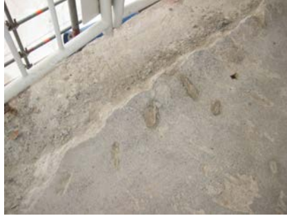
Door de galerijen volledig te strippen, kon er een nieuwe degelijke ondergrond gerealiseerd worden.
