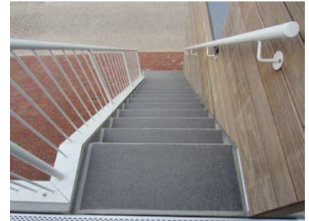
Door ook de trappen te voorzien van een coatingsysteem is het een energiezuinig complex met uitstraling geworden!
