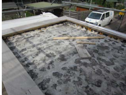
Door het verwijderen van de oude dakbedekking,
