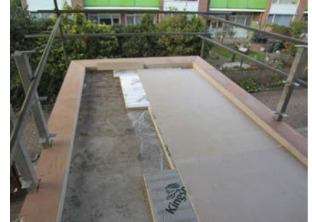
het aanbrengen van isolatie en
