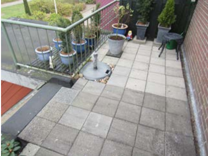
De huidige afwerking voldeed niet meer aan de wensen van de opdrachtgever.
