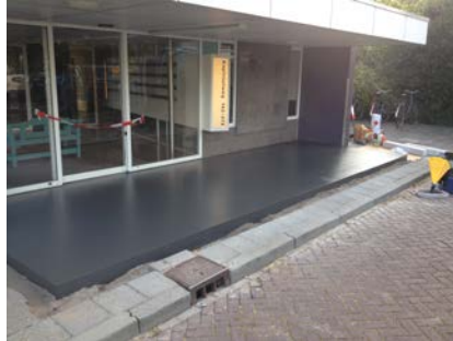
Triflex ProFloor is aangebracht als basis voor het duurzame Triflex systeem.
