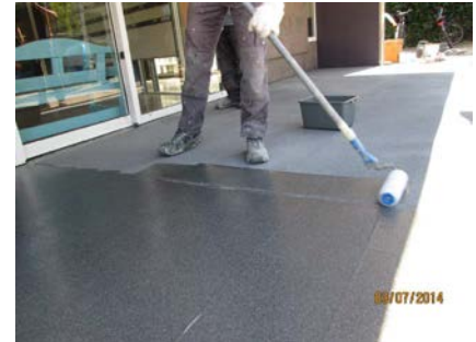
Afwerken met een transparante en UV-bestendige Triflex Finish en het vloerveld is gereed.
