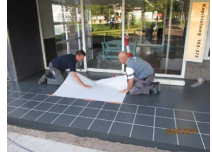
Vervolgens wordt met het Triflex Design folie het patroon aangebracht.
