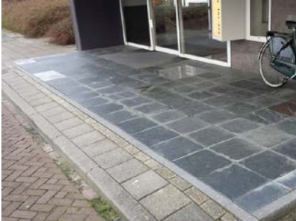
De entree vloer voor de renovatie.
