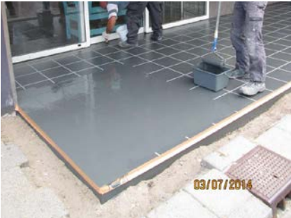
Om het tegelmotief te creëren wordt een laag Triflex Cryl Finish aangebracht in de gewenste kleur.
