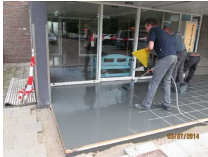
Deze laag wordt vervolgens ingestrooid met Triflex Colour Mix om het juiste effect te verkrijgen.
