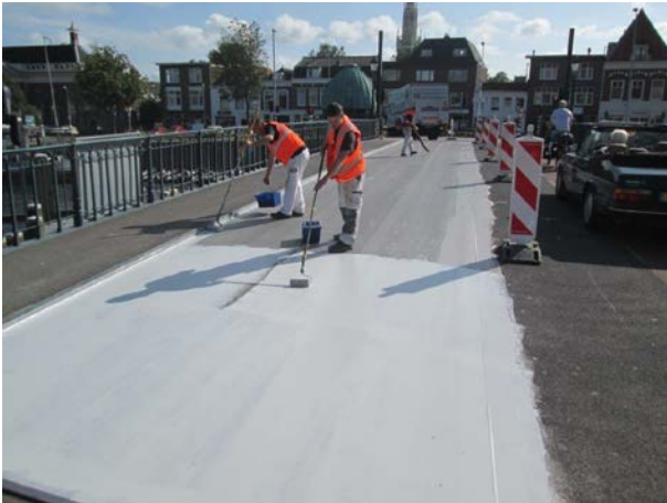
De duurzame slijtlaag van Triflex wordt aangebracht.
