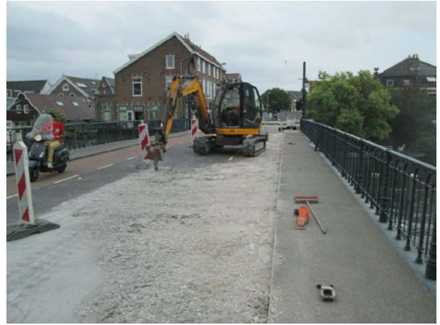
De slijtlaag wordt middels schrapen en stralen verwijderd.
