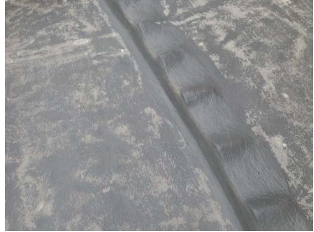
Na de primer is het Triflex ProDetail systeem aangebracht.
