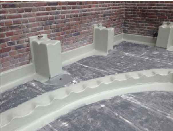
Na het waterdichte systeem is een kleurfinish aangebracht om de gewenste uitstraling te verkrijgen.
