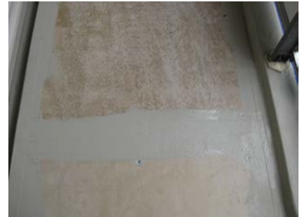
De plaatnaden worden voorzien van het scheuroverbruggende membraan
