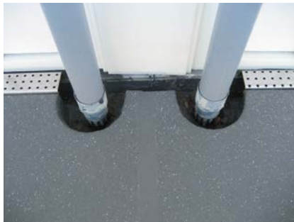
Elk detail voorzien van het waterdichte systeem van Triflex
