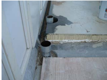
Het aanbrengen van het Triflex ophoogstelsel
