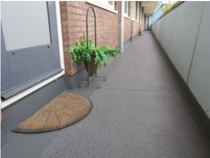
De galerij na de renovatie.
