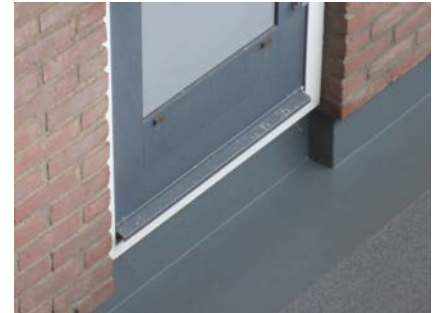
Ook de randaansluitingen zijn voorzien van het waterdichte en scheuroverbruggende membraan.
