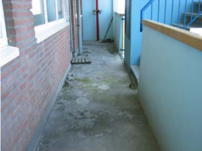
De galerij voor de renovatie.
