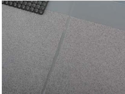
De dilatatie is voorzien van het waterdichte en scheuroverbruggende Triflex membraan.
