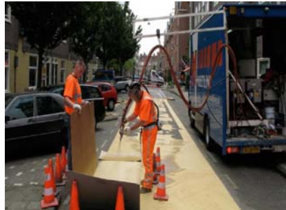
Aanbrengen van Preco Cryl Kaltplastik SP 3K
