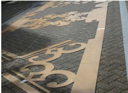
Plaatsen van de sjablonen
