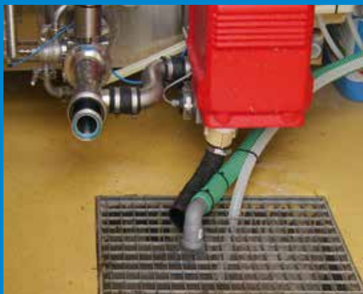
^ Beschermende coating in het tanklokaal
