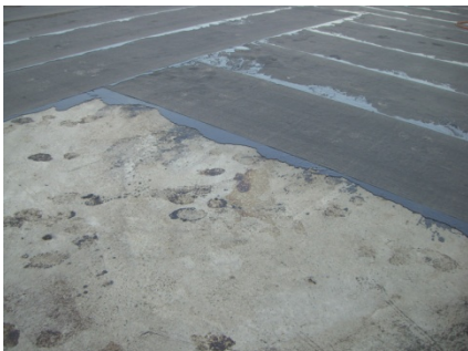
Constructieve ondergrond met dampremmende laag
