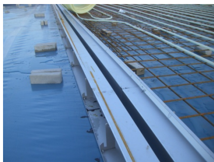
Constructieve dilatatie oplossing
