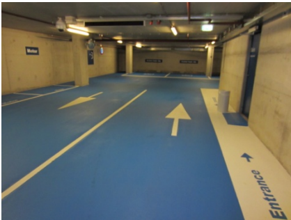
Het eindresultaat: De vloeren voorzien van een coating met de kleur "Philips" blauw
