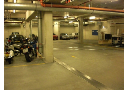
Parkeergarage voor de renovatie
