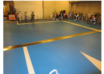
Het eindresultaat: De vloeren voorzien van een coating met de kleur "Philips" blauw
