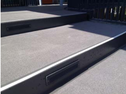
Naast het coatingsysteem zijn de trapneuzen voorzien van een extra witte signalering.
