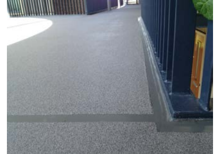
Om de levensduur te verlengen van het systeem en de constructie zijn de dilatatiescheuroverbruggend afgedicht.
