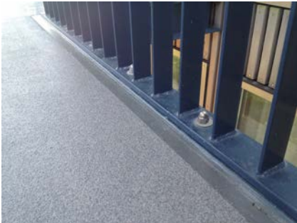
Door het vloeibare materiaal, kan de afwerking tegen het hekwerk geplaatst worden.
