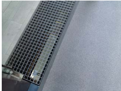
De goten zijn geïntegreerd in het systeem.
