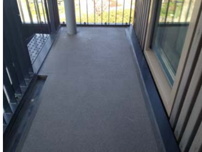
Het Triflex BAS systeem sluit naadloos aan op het trappenhuis.
