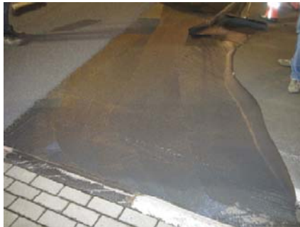
Applicatie van de Triflex Slijtlaag
