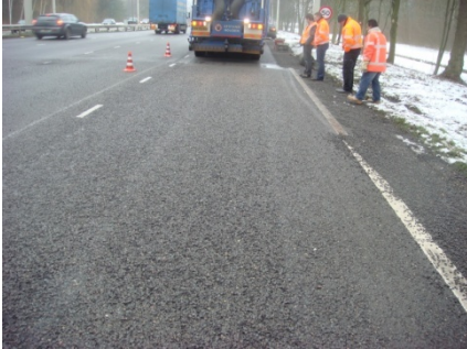
Ondergrondvoorbereiding (ZOAB cleaner)
